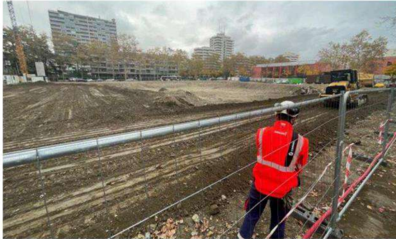
La démolition de l'ancienne clinique est achevée au Tonkin, à Villeurbanne. Photo Olivier Philippe
