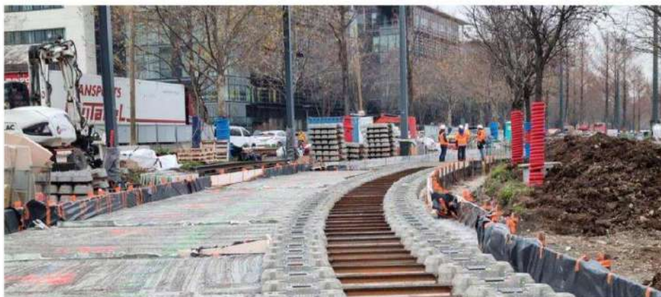
au plus fort du chantier, 250 personnes interviennent en même temps pour poser les rails, les souder, couler du béton ou encore installer des pavés, précise le Sytral. Photo Regis Barnes
