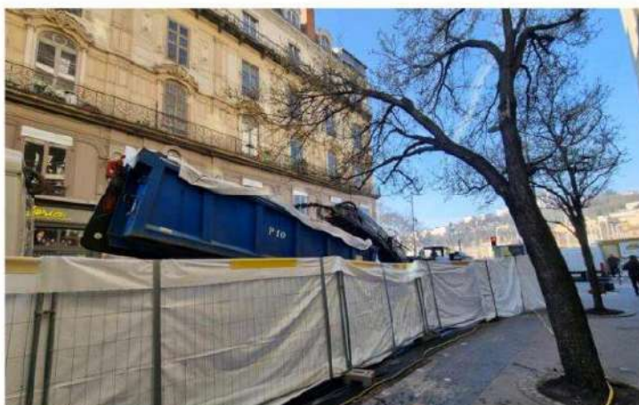
Sur deux jours, les techniciens en charge de l'opération auront retiré une centaine de tonnes d'amiante qui partiront dans un site d'enfouissement. Photo Aline Duret
